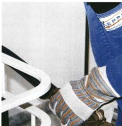
Spart Zeit und Kosten: das einfache Verlegen des vorgewärmten Handlaufprofils auch in Krümmungen
