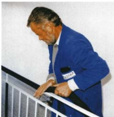
Spart Zeit und Kosten: das einfache Verlegen des vorgewärmten Handlaufprofils auch in Krümmungen
